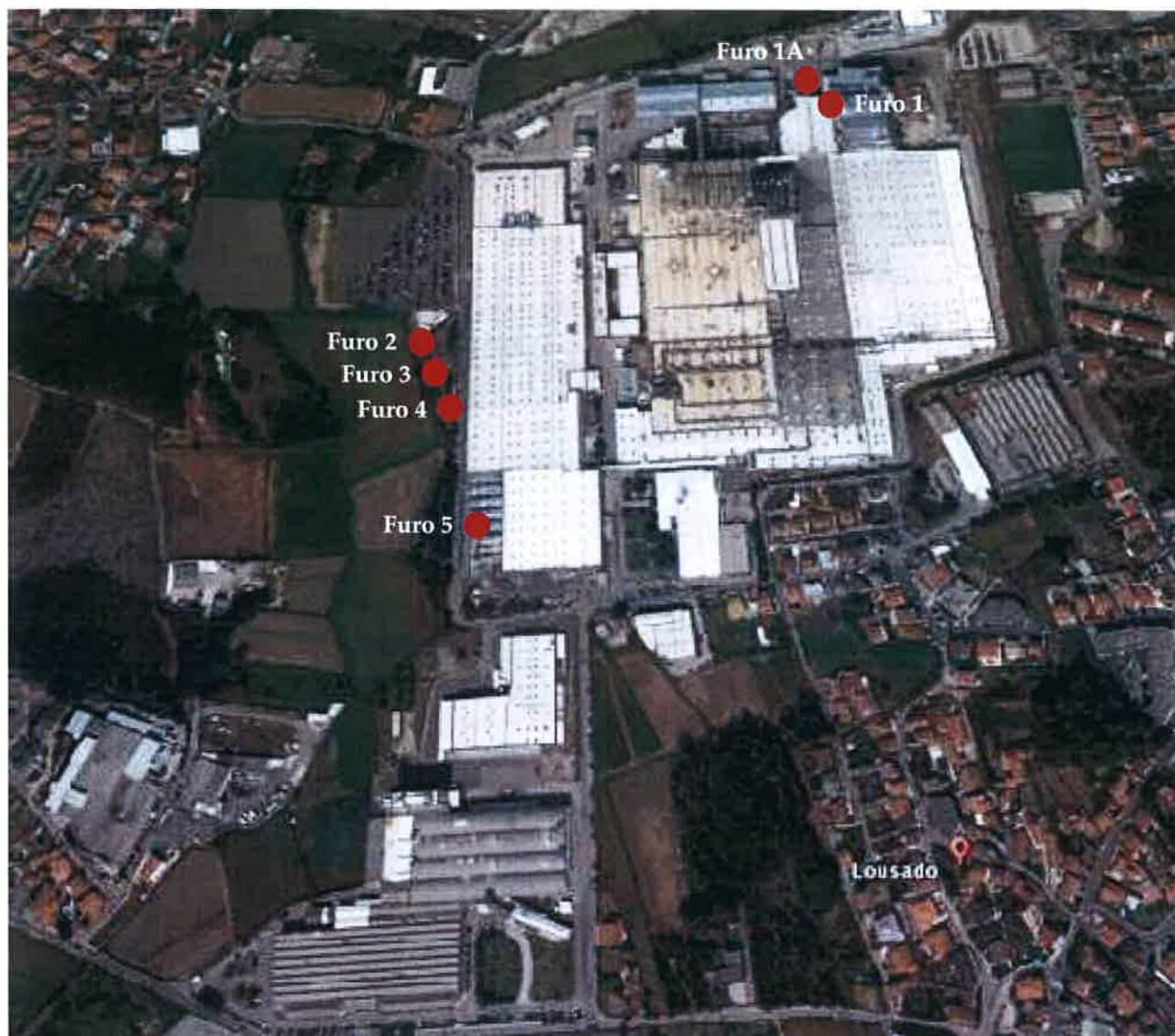
Figura 1: Localização relativa dos furos de captação da continental.
